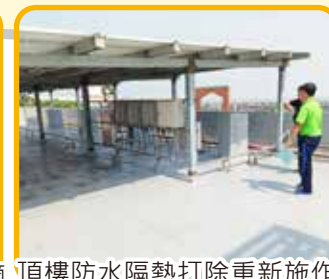
頂樓防水隔熱打除重新施作
